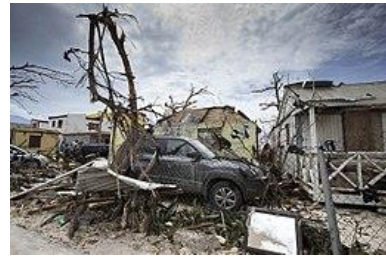
schade na een orkaan
